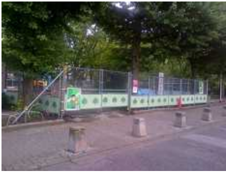
上は、荒川公園の深井戸用の設備工事現場
