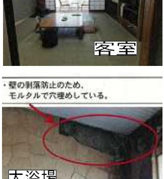
・壁の耐震防護のため、モルタルで穴埋めしている。
