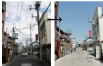
上は、狭隘な道路の電線地中化のビフォー&アフター。下は、町屋駅前の歩道に設置された変圧器。
