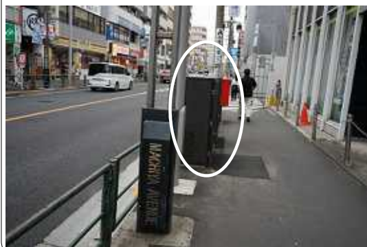
上は、狭隘な道路の電線地中化のビフォー&アフター。下は、町屋駅前の歩道に設置された変圧器。
