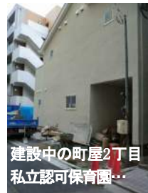
建設中の町屋2丁目 私立認可保育園…
