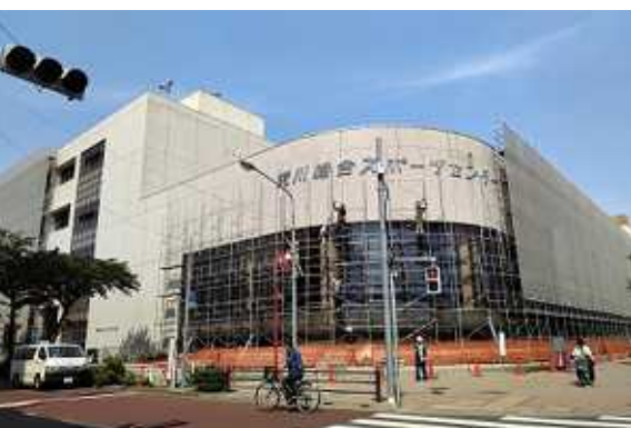
大規模改修に入り足場が組まれたスポーツセンター
