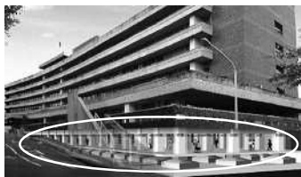
本庁舎免震工事の完成パーツ図
